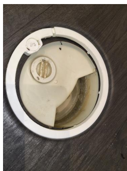
Tettesjiktets tilslutning til sluk - Sluk
