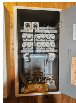
Måler fjernet, ingen strøm til leilighet 1 A mot nordøst.
