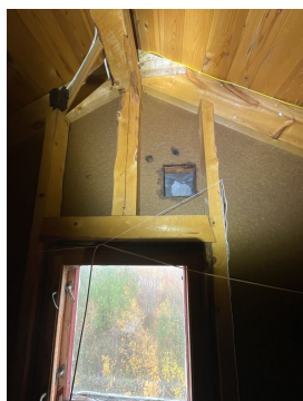
Fuktflekker på bindingsverk loft under vindu.
