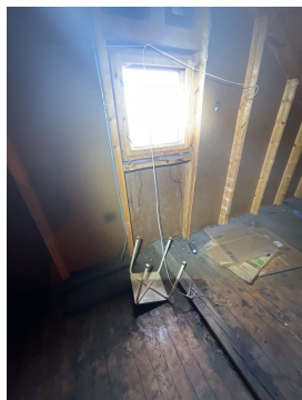
Fuktflekker på bindingsverk loft under vindu.
