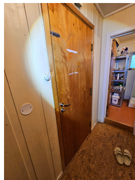
Dør mellom leilighet og trappegang
