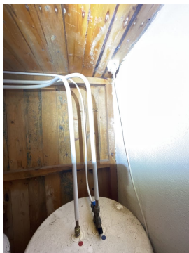
Ikke forskriftmessig tilkobling av strøm etter dagens forskrifter
