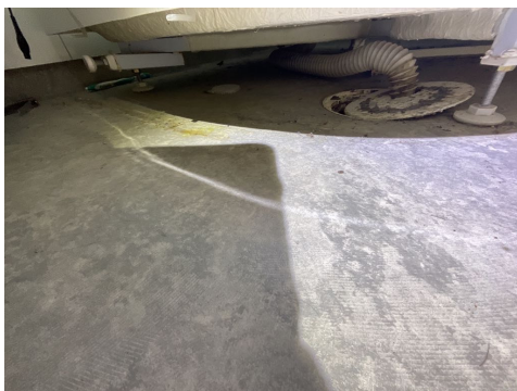
Plastsluk med skrudd klemring.
