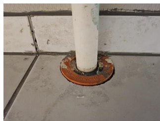
Vanntett sjikt / membran i gulv og vegger - Rørgjennomføring gulv.
