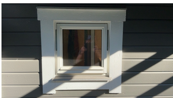
Vindu bad fra 2009.
