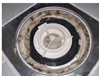
Tettesjiktets tilslutning til sluk - Sluk
