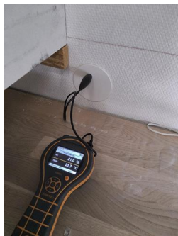
Utført kontroll i tilliggende konstruksjon - Fuktmåling
