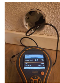
Utført kontroll i tilliggende konstruksjon - Fuktmåling i vegg mot dusjsone.
