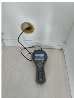
Utført kontroll i tilliggende konstruksjon - Fuktmåling
