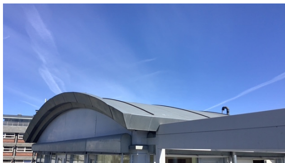
Dels buet takkonstruksjon av limtre og stålkonstruksjoner.
