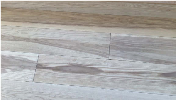
Enkelte tversskjøter på parkett har for kort avstand iht leggeanvisning.
