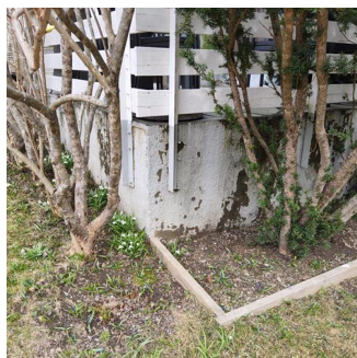
Tilstand på rekkverk og overflatematerialer - Eksempel på overflateslitasjer platting
