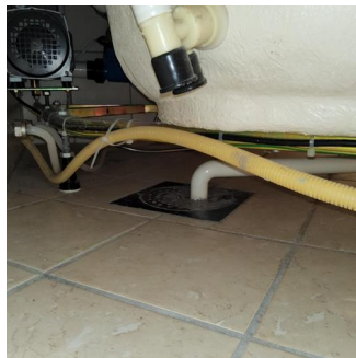
Avløp (inkl. sluk) - Sluk under badekar
