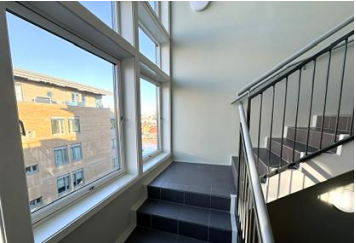
Manglende sikring i trappegang til uteterrassen på tak.
