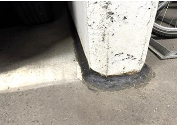
Beskyttelsessokkel på betongsøyle i øvre parkering.
