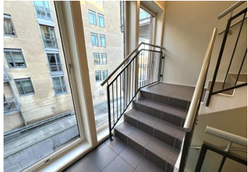
Sikring av vindu i trappegang i 3. etasje.
