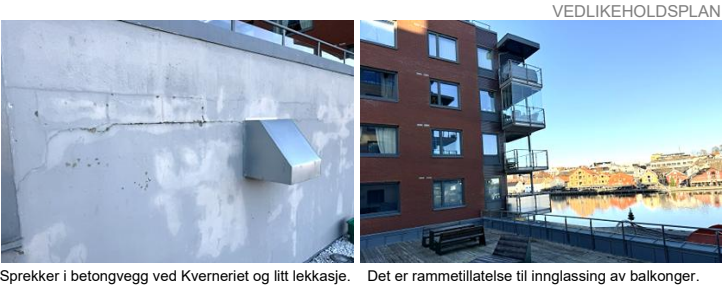
Sprekker i betongvegg ved Kverneriet og litt lekkasje.
