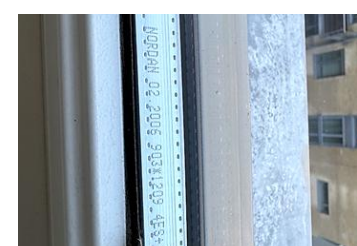
Vinduene er fra byggeår.
