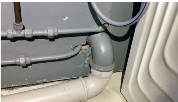
Utett rundt gjennomføringer i våtromsplater.
