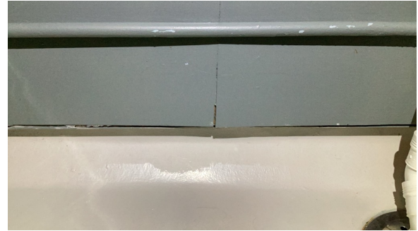
Våtromsplater glipper i bunn.
