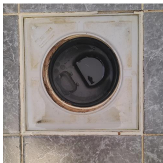
Tettesjiktets tilslutning til sluk - Sluk
