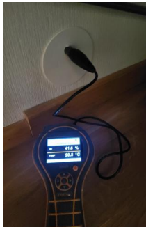
Utført kontroll i tilliggende konstruksjon - Fuktmåling
