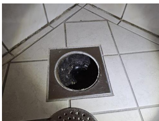
Tettesjiktets tilslutning til sluk - .
