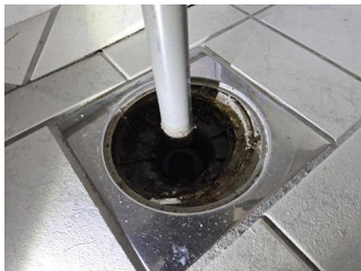
Tettesjiktets tilslutning til sluk - .
