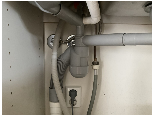
Foto 6: Rørføring under kjøkkenbenk
