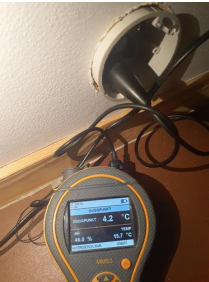
Utført kontroll i tiliggende konstruksjon - Fuktmåling.
