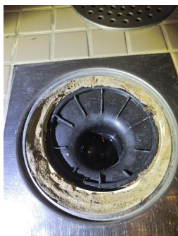
Tettesjiktets tilslutning til sluk - Sluk.
