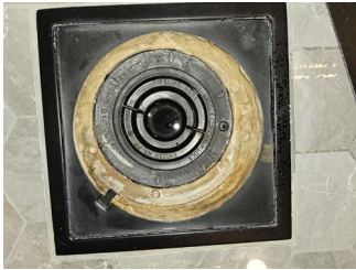
Avløp (inkl. sluk) - Sluk bad 1.etg.
