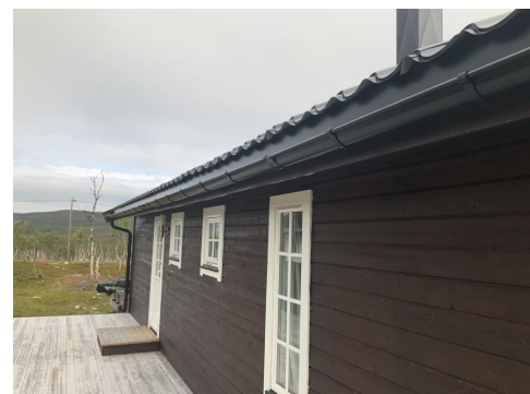
takrenner nedløp og beslag
