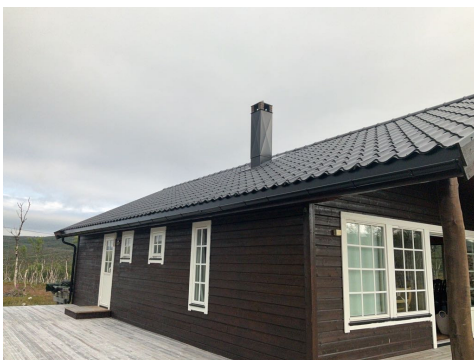
yttertak mot vest befaring 1
