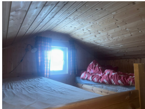
deler av takkonstruksjonen er innredet med hems
