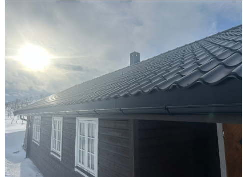
yttertak mot øst befaring 2
