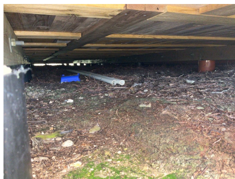
bærende påler av tre (under hytten)
