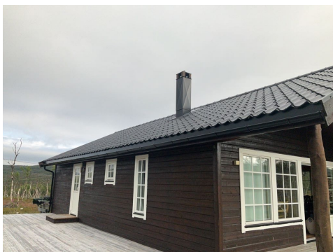
yttertak mot vest befarig 1
