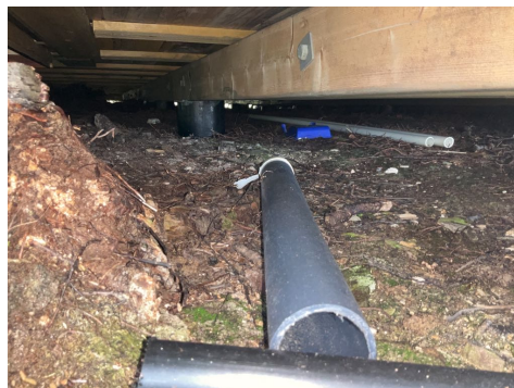
bærende påler av tre (under hytten)
