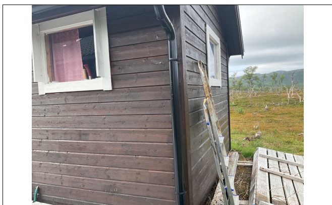
utvendig kledning o g taknedløp takrenner utebod/utedass
