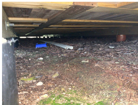
bærende påler av tre (under hytten)
