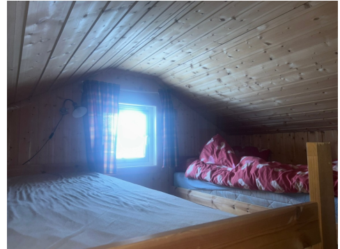
del av takkonstruksjonen er innredet med hems
