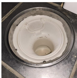
Tettesjiktets tilslutning til sluk - Sluk ved varmtvannsbereider
