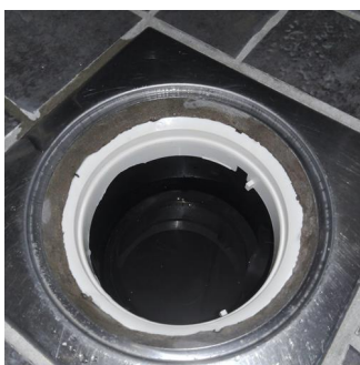
Tettesjiktets tilslutning til sluk - Sluk i dusj
