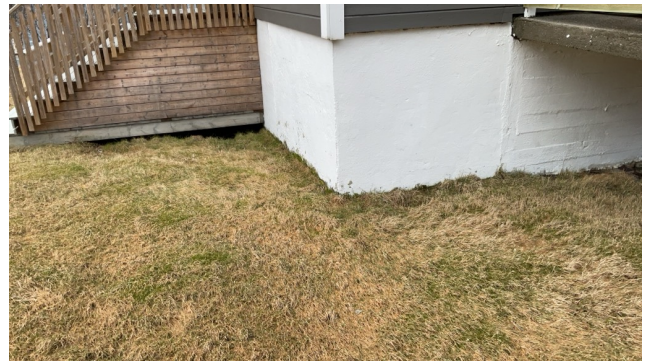
Eksempel på hellende terreng inn mot grunnmur.
