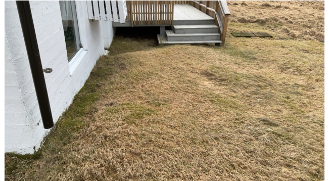
Eksempel på hellende terreng inn mot grunnmur.
