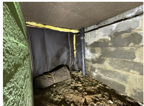
Det er manglende fuktsperre på bakken.
