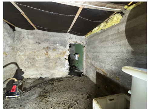
Det er manglende fuktsperre på bakken.
