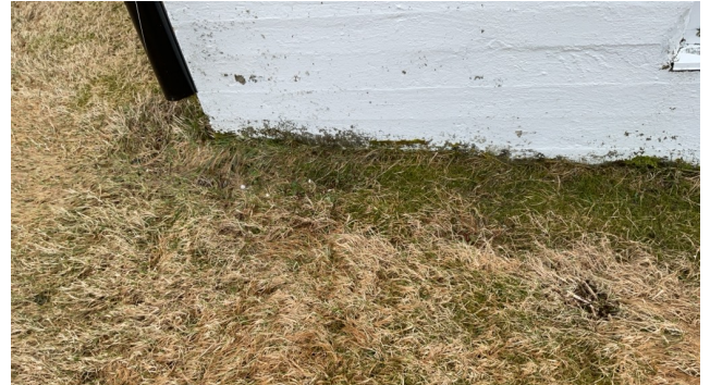
Eksempel på ikke synlig tettesjikt.
