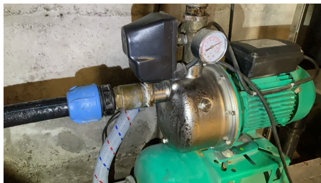
Eksempel på kondensering.
