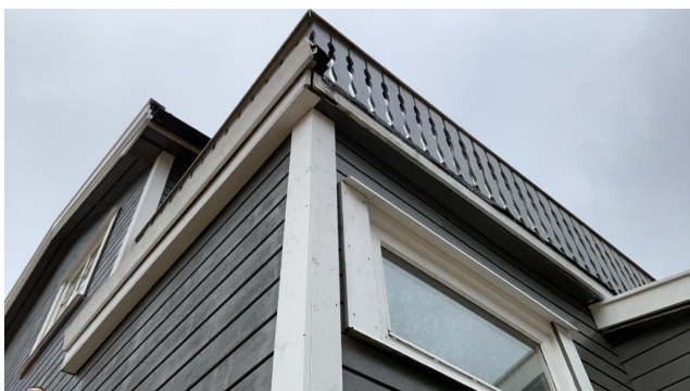
Pulttakkonstruksjon på tilbygg.
