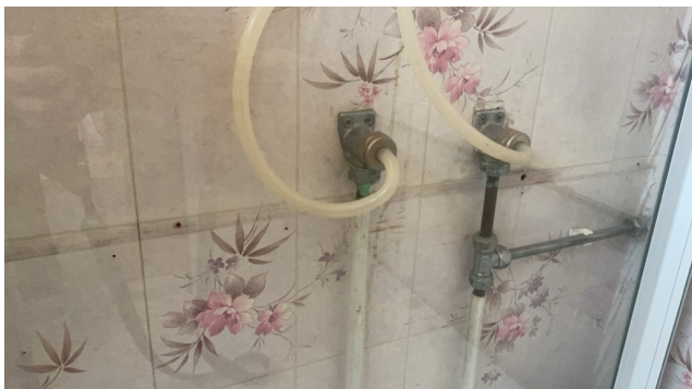
Eksempel på utetthet i våtsone.
