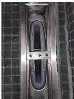
Tettesjiktets tilslutning til sluk - Sluk
