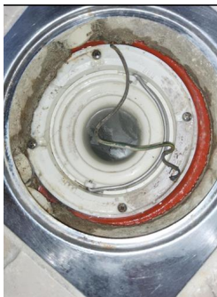
Tettesjiktets tilslutning til sluk - Sluk
