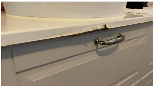
Innredning har skader.
