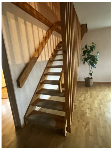
Foto 1: Tretrapp med åpne trinn og spilerekkverk
