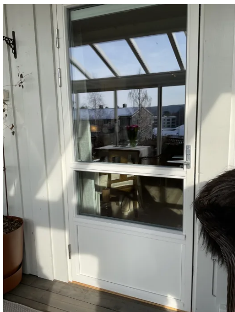
Malt terrassedør med isolerglass fra 2024
