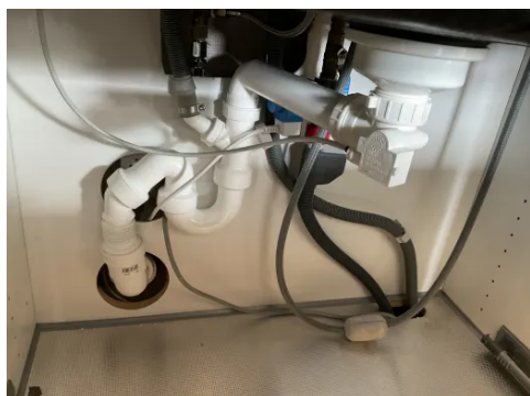
Innvendig avløpsrør skiftet i 2024
