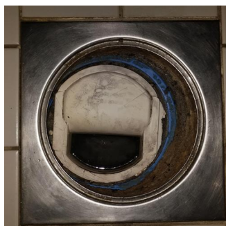
Vanntett sjikt / membran i gulv og vegger - Sluk bad.
