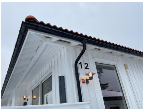
Takrenner og nedløp
