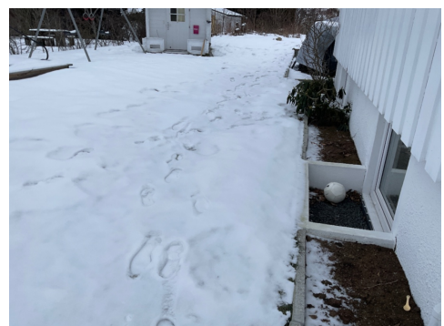
Terrengforhold på endeveggen av huset
