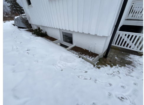
Grunnmur er utvendig pusset og malt
