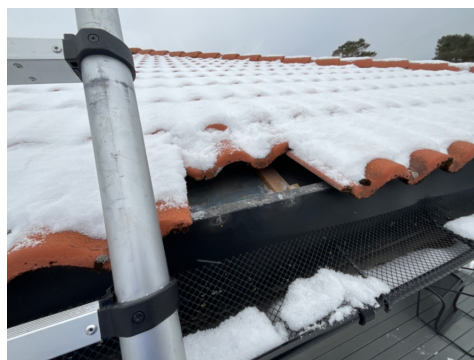
Taktekking, undelagsbelegg og lekter
