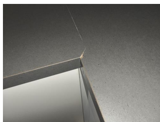
Innredning - Skade i benkeplate
