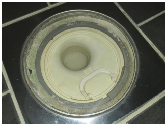
Tettesjiktets tilslutning til sluk - Sluk
