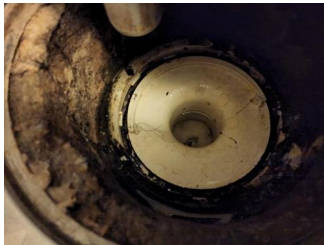
Tettesjiktets tilslutning til sluk - Sluk bad
