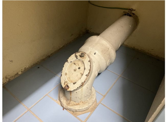
Foto 32: Avløpsrør av støpejern fra byggeår. Synlig stakeluke.
