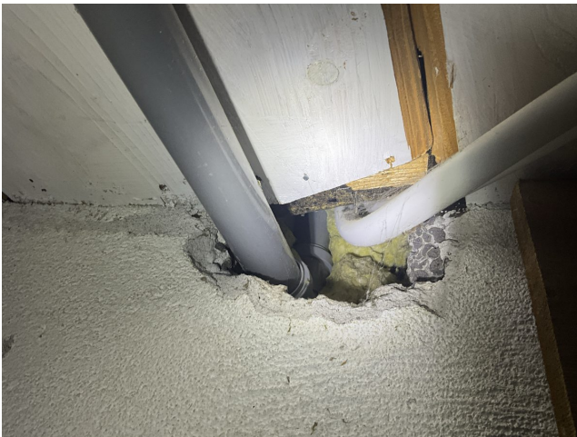
Foto 19: Gjennomføring av rør til dusj/plastsluk i kjeller
