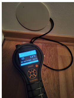
Utført kontroll i tiliggende konstruksjon - Fuktmåling
