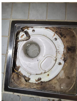
Tettesjiktets tilslutning til sluk - Sluk
