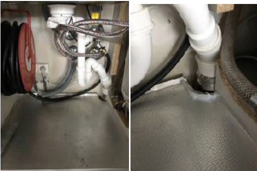
Brannslangen med tilkoplingskran.
