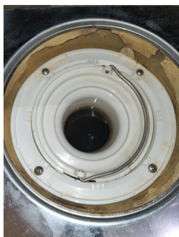
Tettesjiktets tilslutning til sluk - Sluk bad
