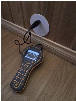
Kontroll i lukkede konstruksjoner - Fuktmåling
