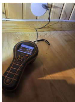
Utført kontroll i tilliggende konstruksjon - Fuktmåling
