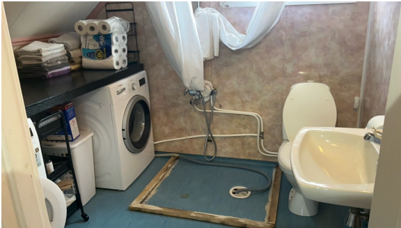
Oversiktsbilde av bad.
