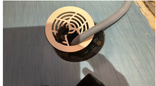
Kontroll av sluk.
