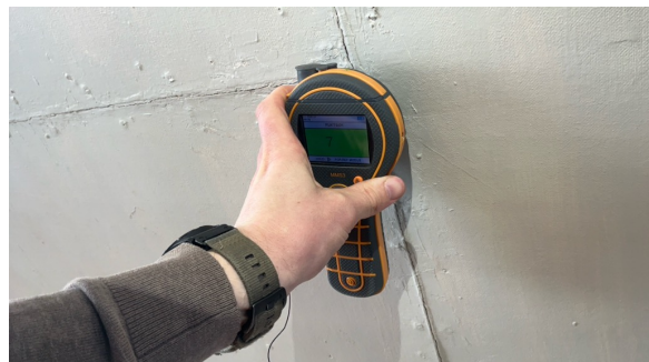
Fuktmerker i himling loftsetasje enkelte steder. Fuktsøk viste normale verdier.
