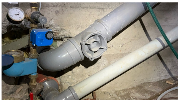
Stakeluke i kjeller.
