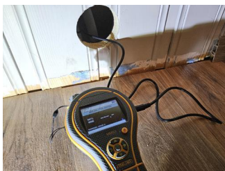
Utført kontroll i tilliggende konstruksjon - Fuktmåling bad 1. etg.
