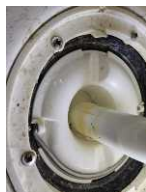
Tettesjiktets tilslutning til sluk - Sluk i bad.
