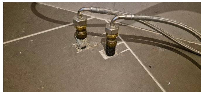
Rør gjennom gulv bad dusjkabinett
