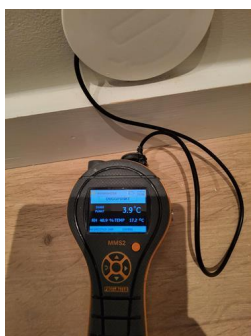
Utført kontroll i tilliggende konstruksjon - Fuktmåling
