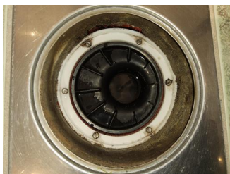
Tettesjiktets tilslutning til sluk - Sluk, bad.
