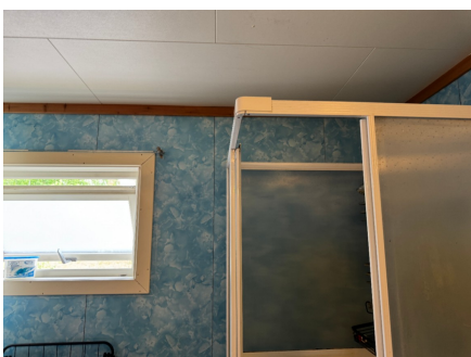
Vindu plassert i dusjsone/våtsone
