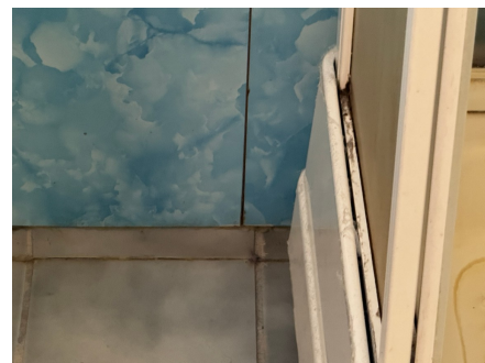
Ikke sokkellist og sprekker i skjøter på baderomsplater
