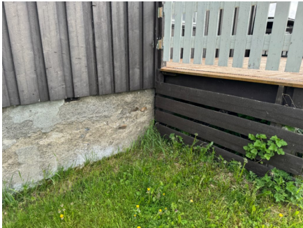
Avflassing på overflater av grunnmur utvendig
