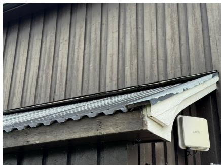
Taktekking på utbygget del i stue
