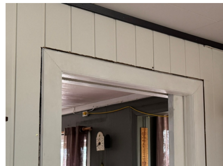
Ufagmessig avslutning mellom døråpning og panelplater
