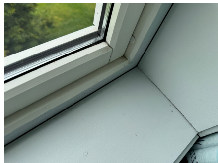
Estetisk ufagmessig utførelse av utføring rundt vindu
