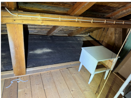
Flis som isolering av takkonstruksjon på opprinnelig del
