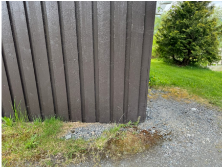
Treverk nært terreng
