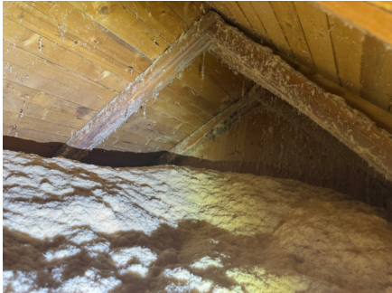
Tilleggisolering på loft
