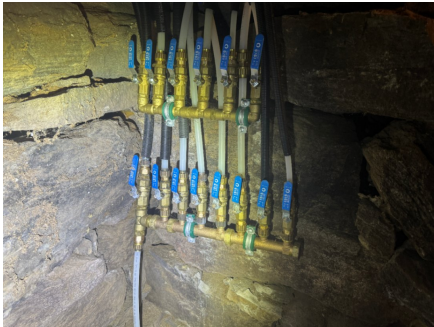
Samlestokk for rør i rør vannrør i jordkjeller under soverom
