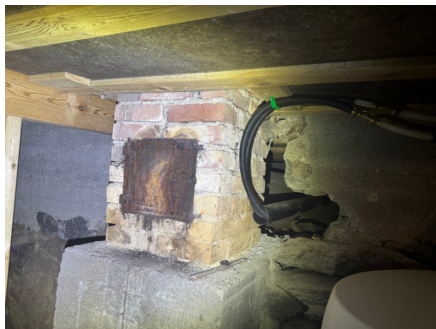
Sotluke plassert i jordkjeller
