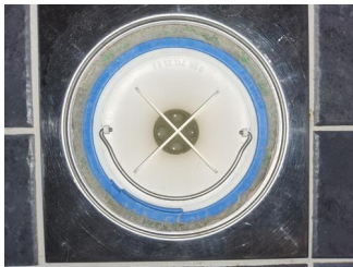
Tettesjiktets tilslutning til sluk - Sluk på badrom
