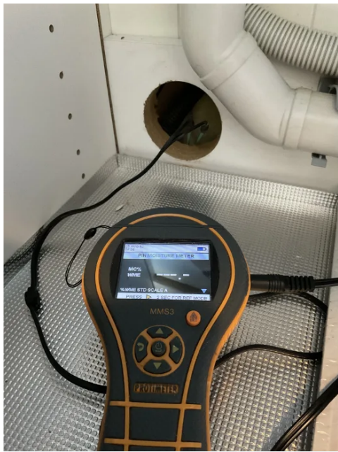
Fuktmåling ved hulltaking uten unormale verdier
