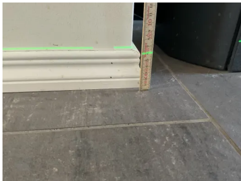
Ingen unormale verdier ved måling
