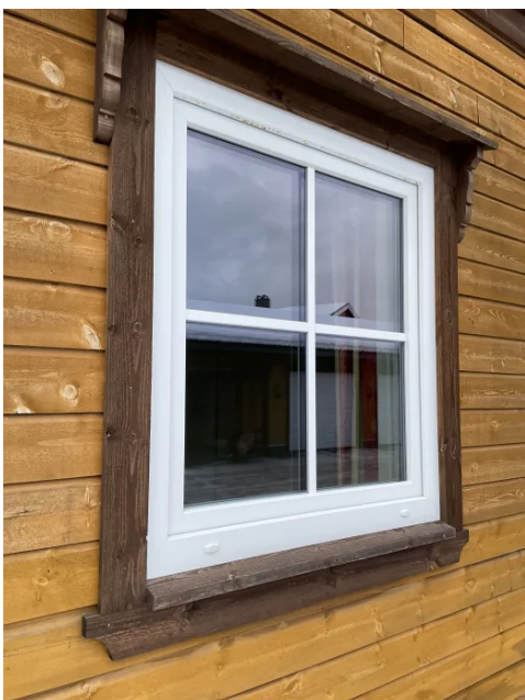
Utvendig vannbrett i malt utførelse
