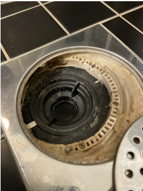
Slukmansjett synlig ført under klemring
