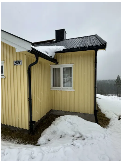
Drensrør montert på utkast.
