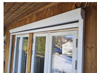
Vinduer og omramming - Solskjerming på vinduer i stue
