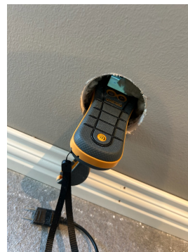
Fuktmåling i vegg bak dusjsonen.
