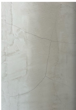
Mangelfullt arbeid rundt utkraging ved pipe/brannmur.
