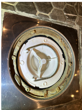
Plastsluk med synlig slukmansjett under klemring.
