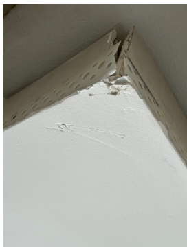
Mangelfullt arbeid rundt utkraging ved pipe/brannmur.
