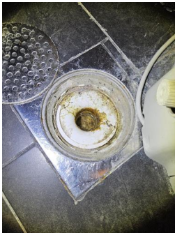
Tettesjiktets tilslutning til sluk - Sluk.
