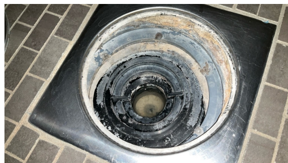
Plastsluk. Synlig membran/ slukmansjett i sluket. Ukjent type membran/tettesjikt.
