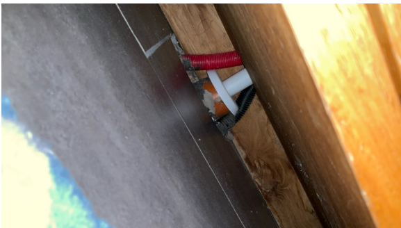
Rørgjennomføringer i tettesjikt.
