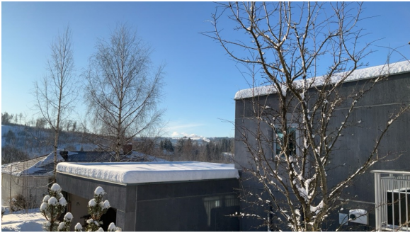
Taktekingen er snødekt på befaringsdagen.
