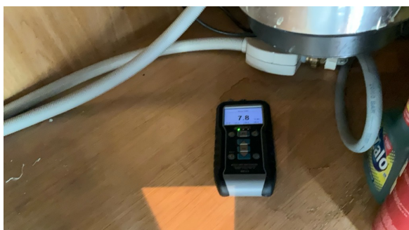
Ved bruk av fuktindikator på utsatte steder registrerte jeg ingen unormale verdier.
