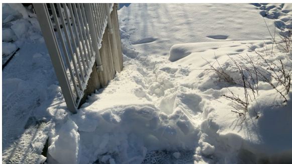
Ved terrasse i hage: Manglende rekkverk.
