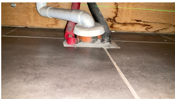
Rørgjennomføringer i tettesjikt.
