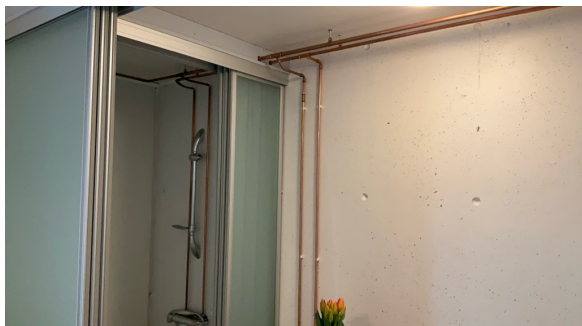
Det er synlig røropplegg.
