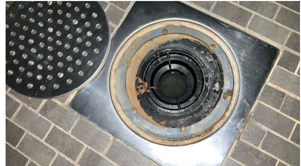
Sluk i dusj: Plastsluk. Synlig membran/ slukmansjett i sluket. Ukjent type membran/tettesjikt.
